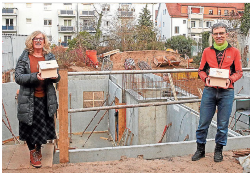
Hoffen auf weitere Spenden für ihr Wohngemeinschaftsprojekt: Gisela Wrensch und Paul Szász auf der Baustelle in Schwetzingen. Foto: Lenhardt
